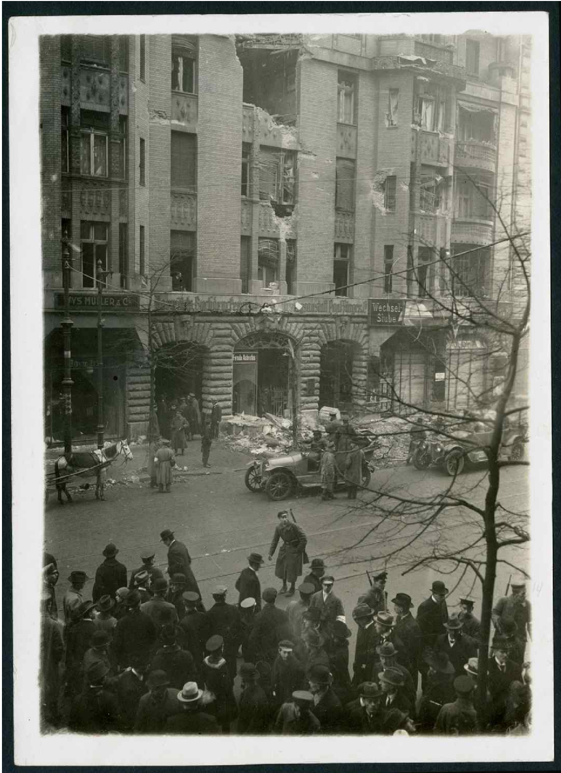
Façade criblée de balles de l'immeuble du Vorwärts à Berlin, 11 janvier 1919
